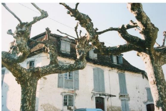
Maison Apazarena avant réhabilitation...
