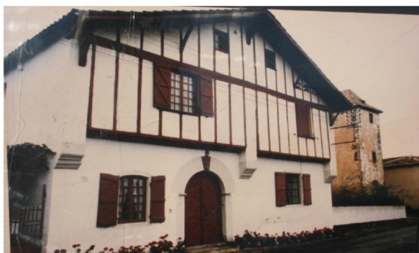
Maison Merchotenia avant réhabilitation....
