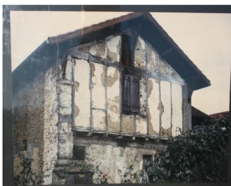
Maison Ginartenia avant réhabilitation...
