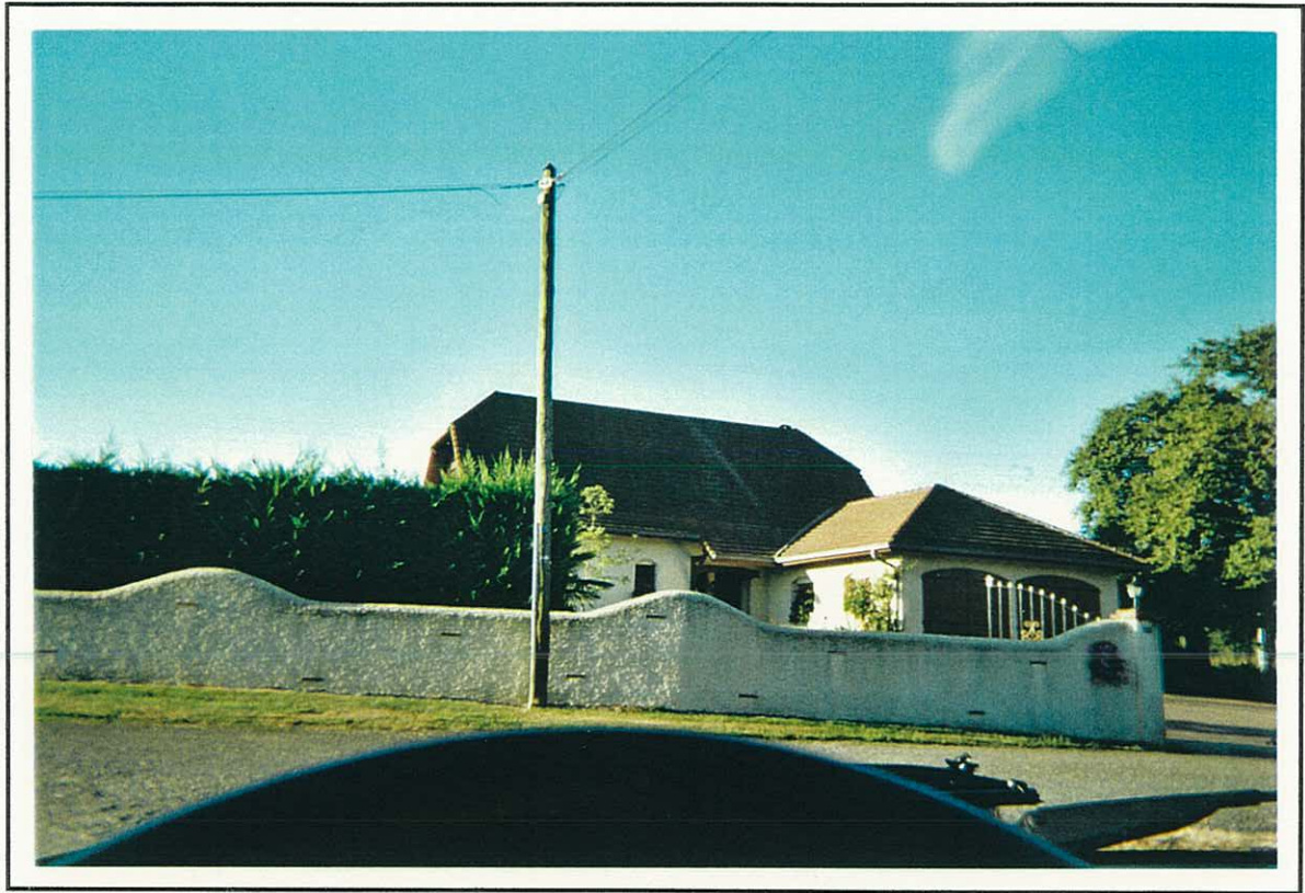
Exemple d'habitation construite dans les années 90, au style béarnais classique
