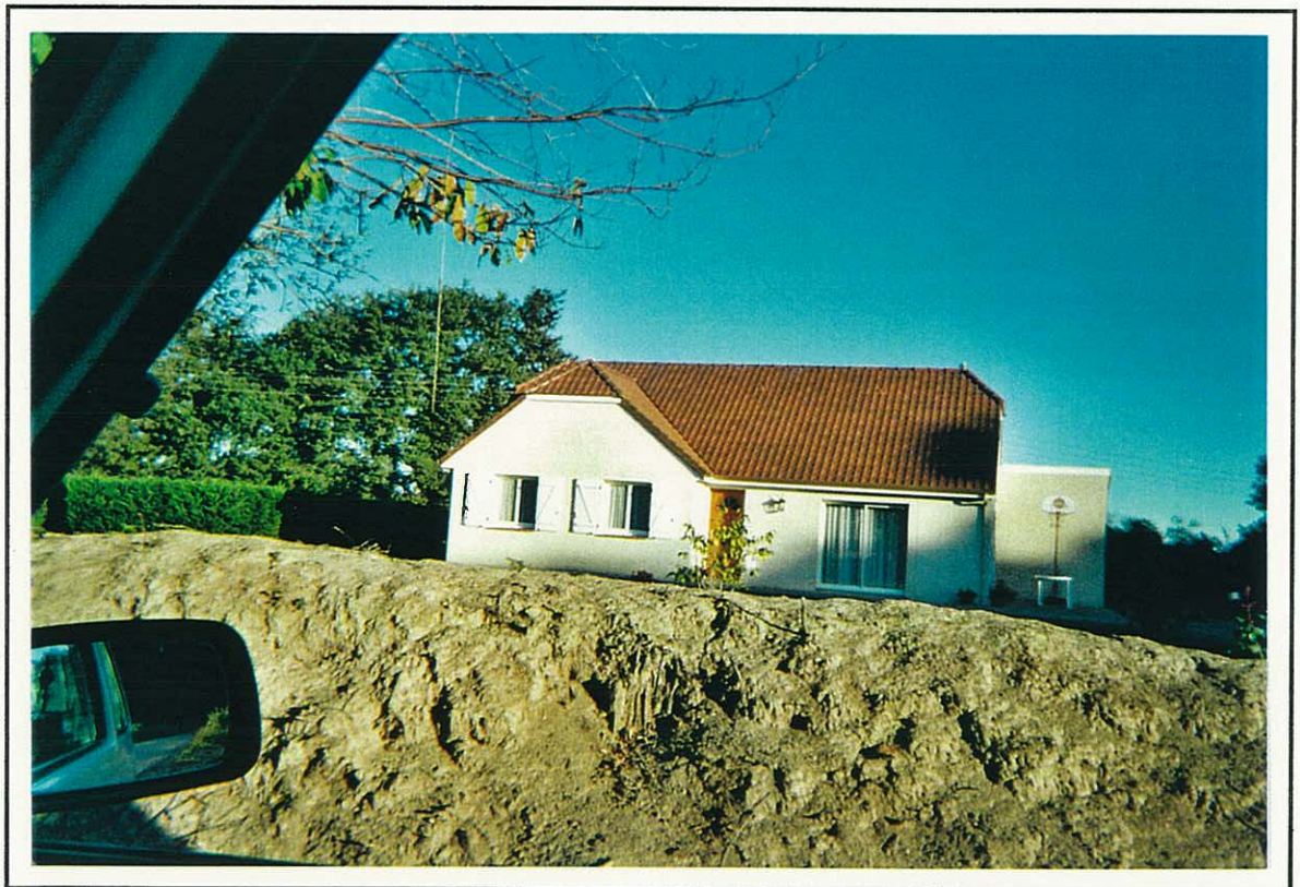
Exemple d'habitation construite plus récemment au style béarnais mais avec quelques traits plus modernes
