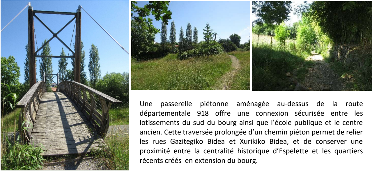
Passerelle et chemin piéton pour la traversée de la RD918 Source : APGL – 05-2020
