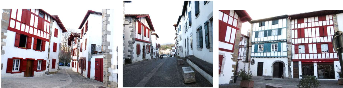
Front bâti continu dans le centre bourg d'Espelette
