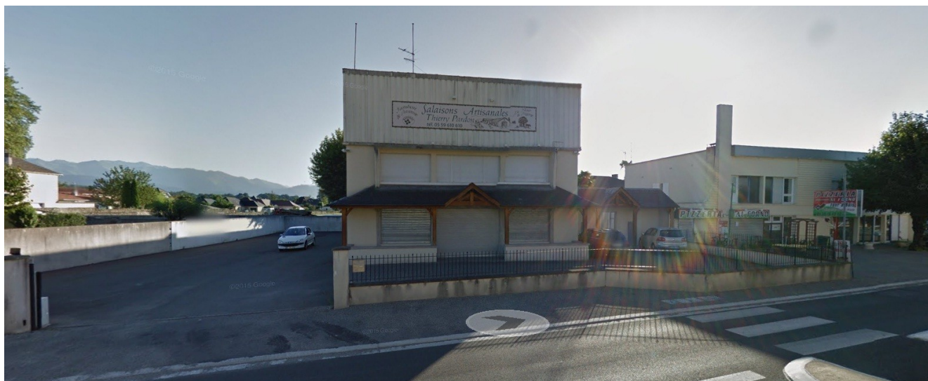
Salaisons Pardon avenue de la Gare
