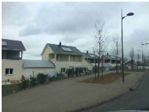
L'opération de logements dans le bourg part la commune par exemple utilise cette énergie pour l'eau chaude sanitaire.
