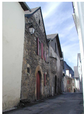
Habitat linéaire le long de la rue principale
