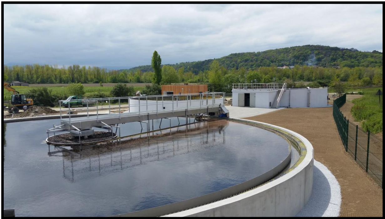
Station d'épuration récemment aménagée
