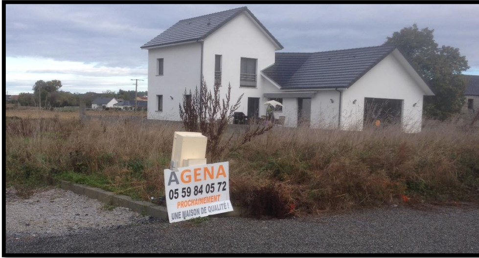
Construction récente sur la commune de Boeil-Bezing
