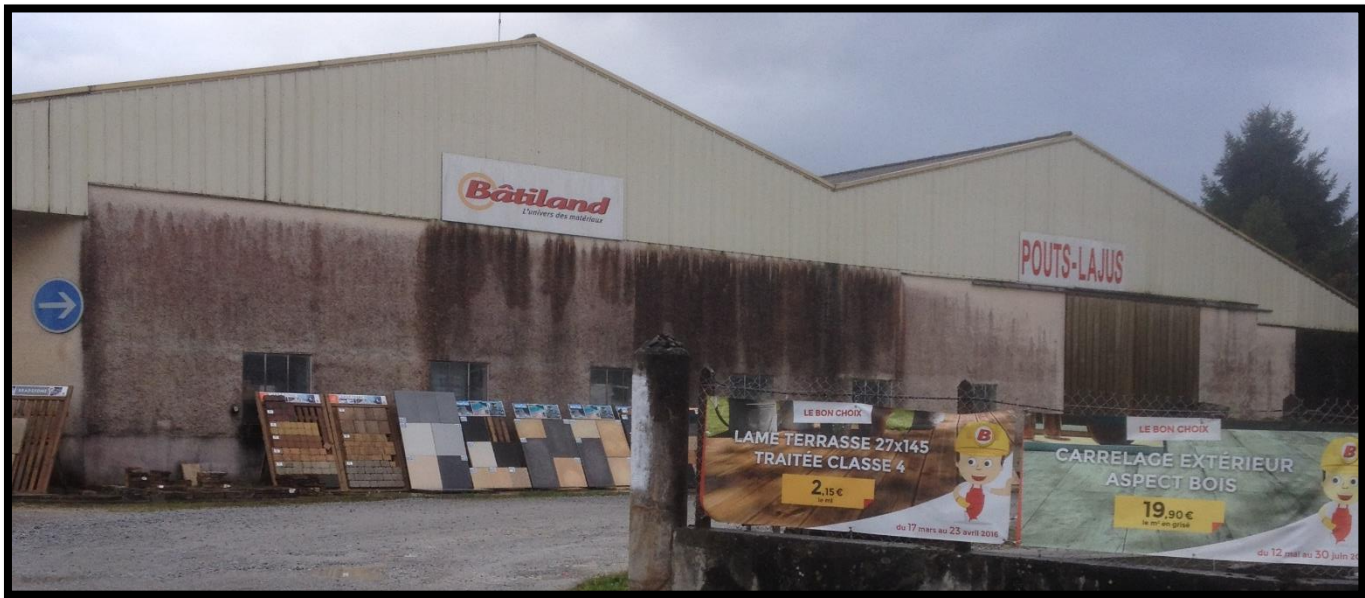
Entreprise Batiland – Pouts Lajus sur la commune de Boeil-Bezing
