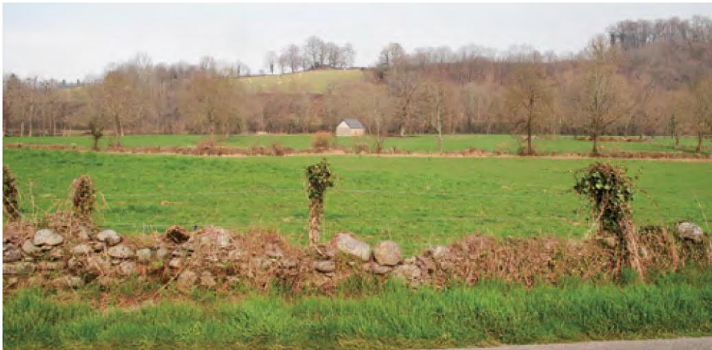
Murs en pierres sèches. Les matériaux ramassés dans le champ ou la prairie constituent le mur. Ci-dessus le couronnement est fait avec de grosses pierres.
