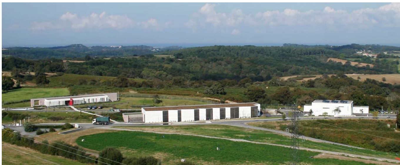
PHOTO N°4 : VUE AERIENNE DU CENTRE TECHNIQUE ET ADMINISTRATIF
