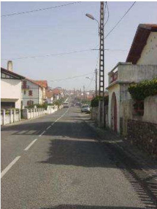
Poursuite enterrement lignes aériennes etc.
