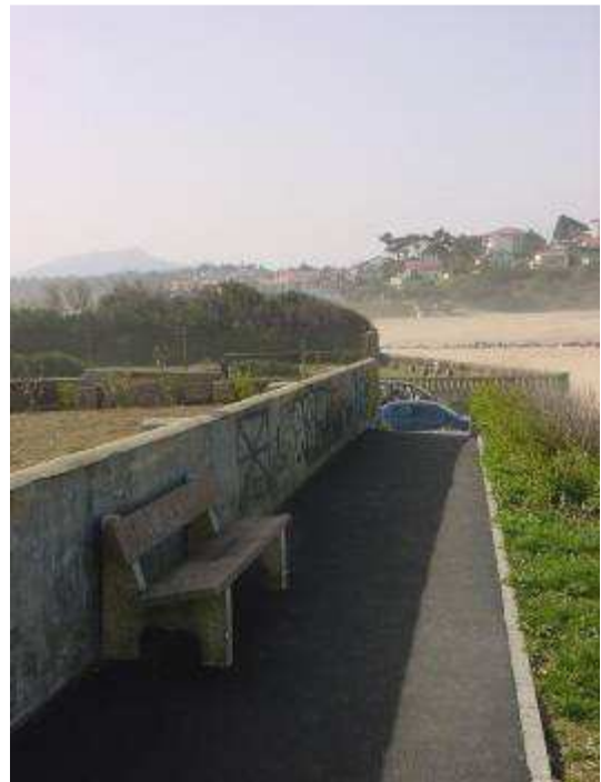
Equipement et aménagement plage des Embruns
