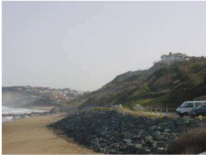
Végétalisation de la consolidation des falaises à Parlementia
