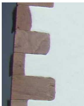
Le chaînage de pierre traditionnel, en grès rose avec un enduit venant à fleur de la pierre de taille
