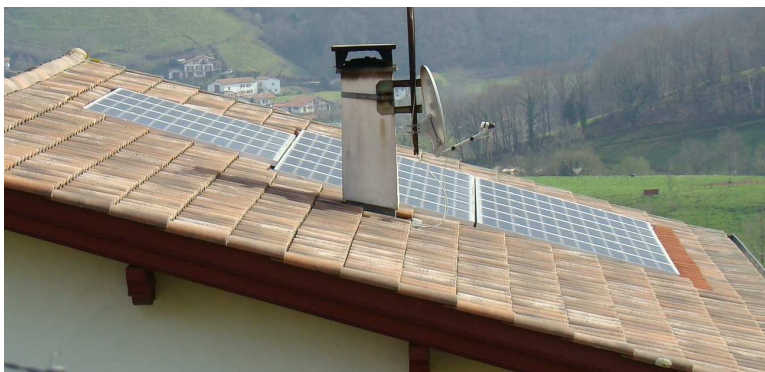
Les capteurs ne doivent pas dépasser la surface de la couverture
