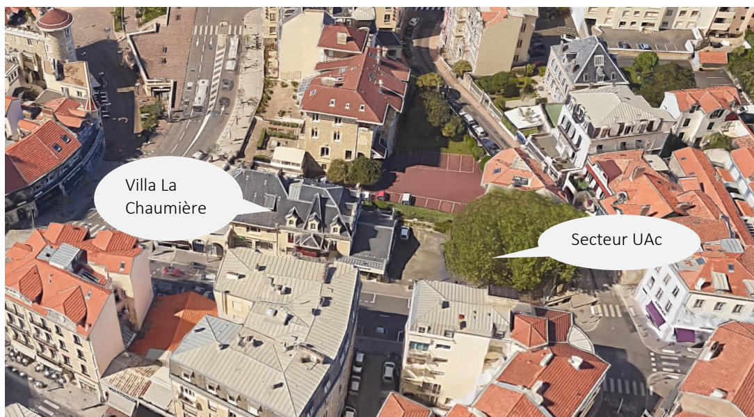
Localisation du site par rapport à la Villa Chaumeil, le long de l'avenue de Verdun (source : Google)
