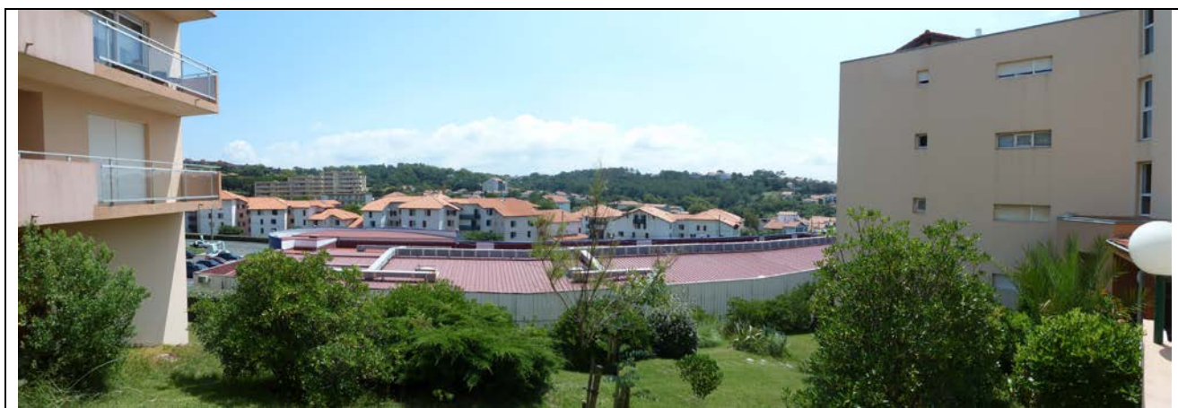
Vue panoramique entre les immeubles situés au nord-ouest (secteur UDa) ; en contrebas l'ancien magasin « Leclerc » démoli situé en zone UG et en secteur UGi au P.L.U modifié (ph BW 28-07-2011)
