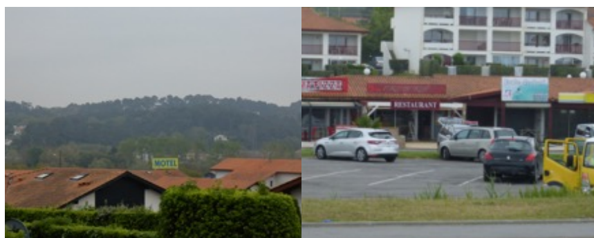
Enseignes sur toiture en infraction à Bidart
