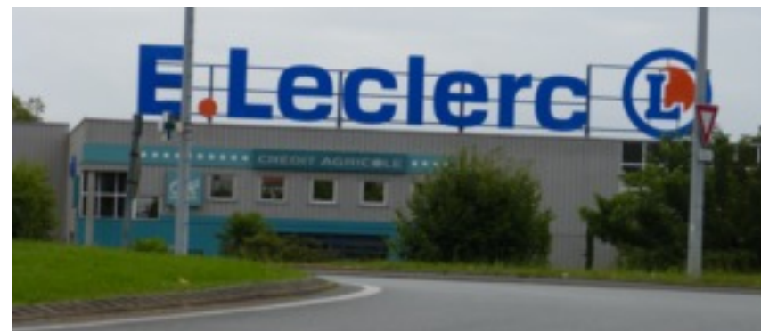
Enseigne sur toiture à Bayonne dont les structures sont visibles
