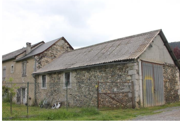
Sa maçonnerie est composée de galets de rivière provenant du Gave d'Ossau
