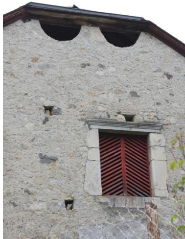
Couverture en croupe et doubles ouvertures pour l'aération des combles
