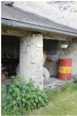
Sa maçonnerie est composée de galets de rivière provenant du Gave d'Ossau
