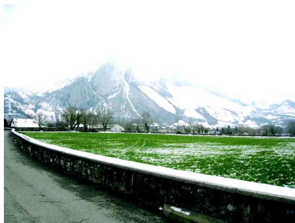
Muret de pierre moellon clôturant les unités agricoles en fond de vallée
