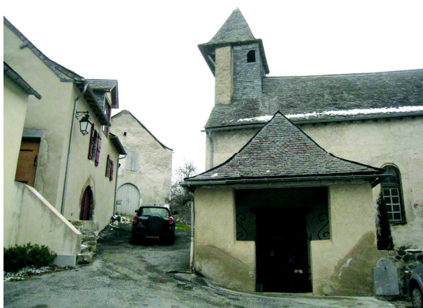
Toiture en ardoise
