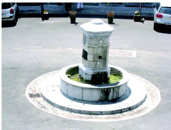
Fontaine centrale - Place François Sarailhé à Bedous
