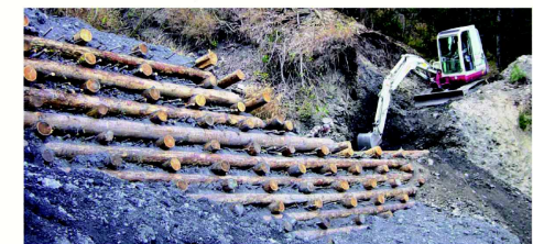
Exemple de réalisation d'un soutènement par ouvrage bois (Hautes-Alpes) dans le cadre des missions d'intérêts général pour la prévention des risques naturels
