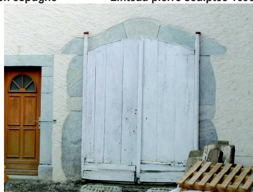
Baie avec jambage et linteau en granit
