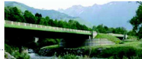
Franchissement du Gave d'Aspe
