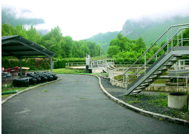
Station d'épuration de Lees
