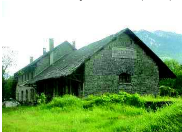
Gare de Bedous actuellement désaffectée
