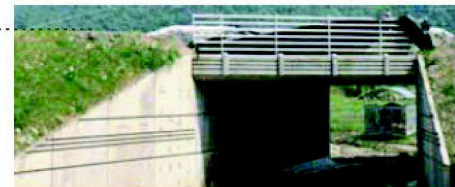
Ouvrage mixte hydraulique et boviduc
