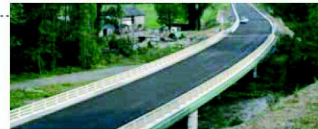
Franchissement du Gave d'Aspe
