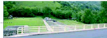
Franchissement du Canal EDF
