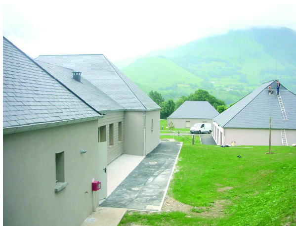
Abri montagnard, nouveaux locaux, Bedous
