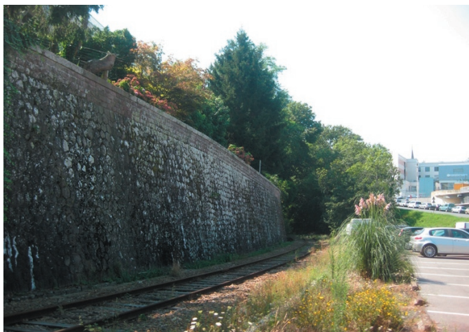
la voie ferrée et le mur de soutènement
