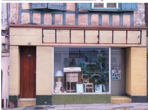
Piles en pierre de Bidache et façade pan de bois masquées par une maçonnerie
