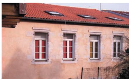
Menuiseries PVC à imposte fixe. Adaptation des menuiseries à la baie par éléments standardisés
