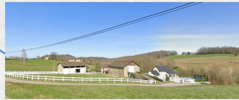
Ancienne entreprise Asson Aluminium
