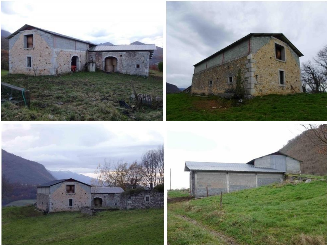
Vues du bâtiment dit Lousplaas (source : Commune d'Asson)
