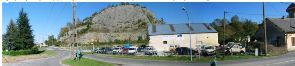
ANCIENNE CARRIERE SAINT-MICHEL, EN BORDURE DE LA RD 920, EN ENTREE SUD D'ARUDY
