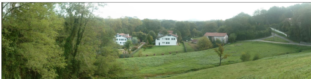
Habitations en secteur Ni du projet de PLU qui sont soumises aux dispositions du PPRI (octobre 2017). Source : APGL.
