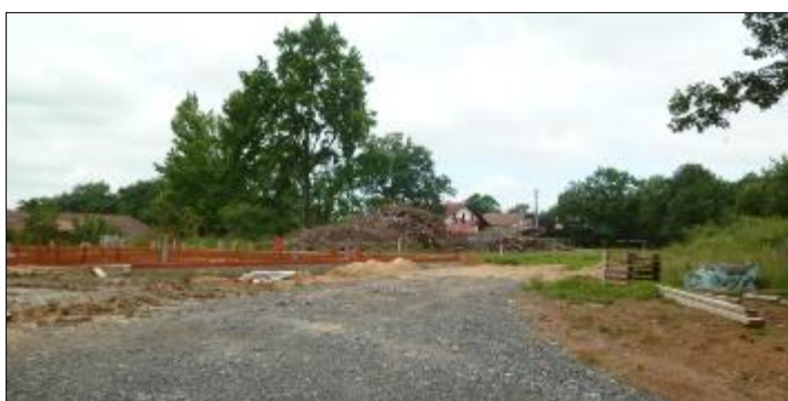
Vue sur un chantier en cours le long de la RD255 (juin 2018) (localisé en flèche rouge sur la carte). Zoom sur la zone UL 'sud'.
