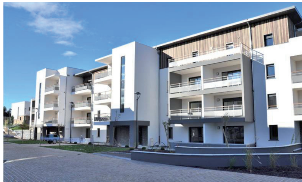
Exemple de bâtiment à bonne échelle (hauteur, active, rythme et trame verticale de la façade, rdc ouverts)
