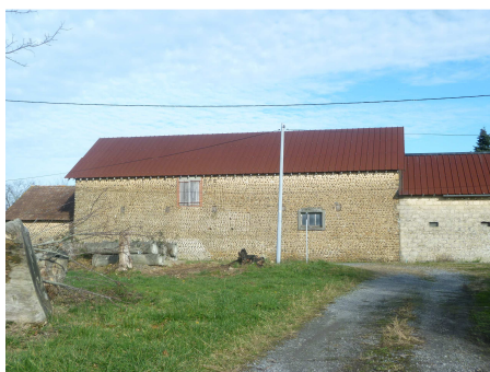
Corps de ferme en alignement sur voirie
