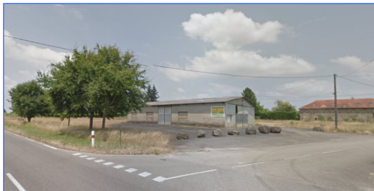
Vue du local depuis la RD 28
