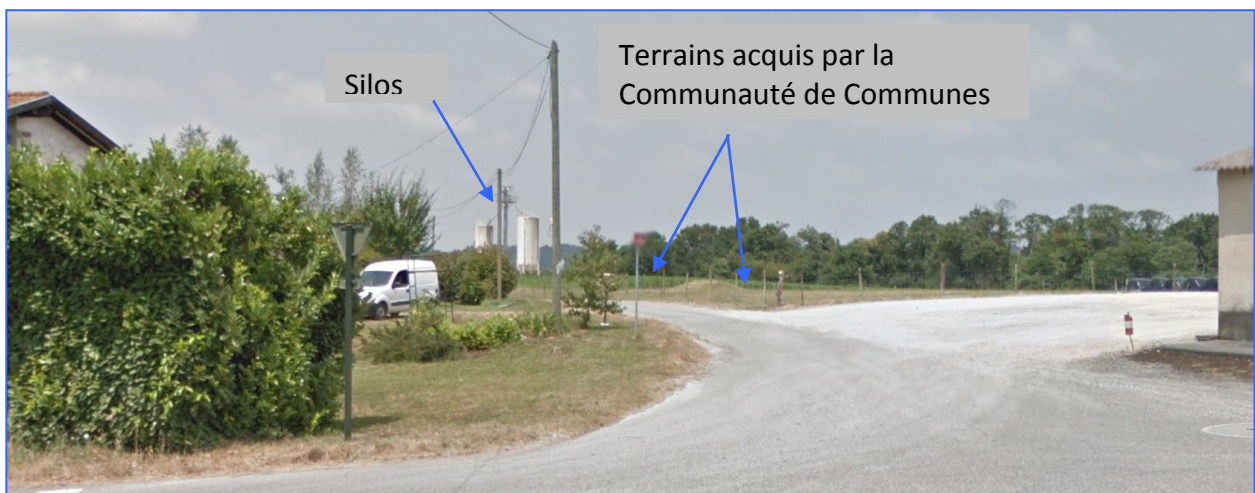
Vue du site depuis la RD 28 Source : Google, 2013
