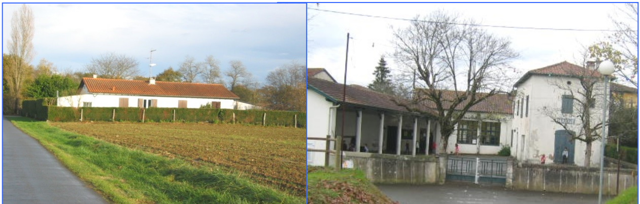
Une construction isolée le long d'une voie de circulation et l'école (ancienne mairie)
