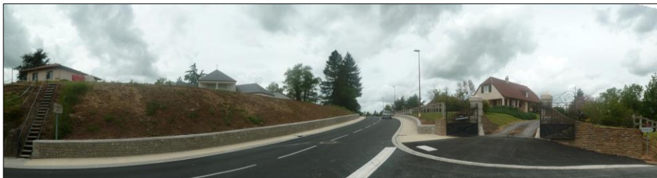
L'entrée Est du quartier de la Gare, en limite communale avec Navarrenx. Source : APGL.
