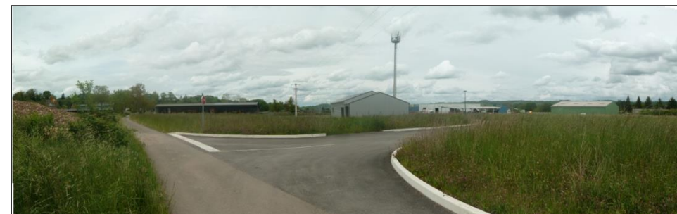
Lotissement d'activité 'La chapelle' viabilisé et en cours de construction. Source : APGL.
