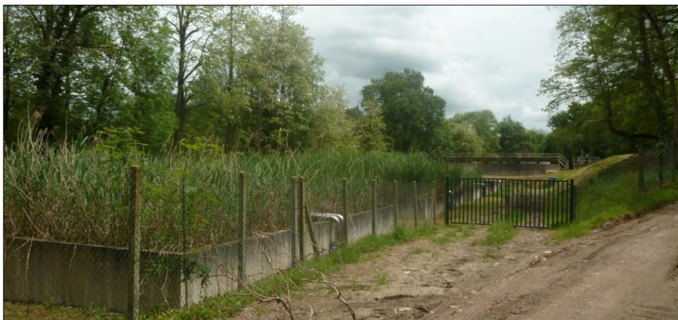
Vue sur la station d'épuration près du gave d'Oloron. Source : APGL.
