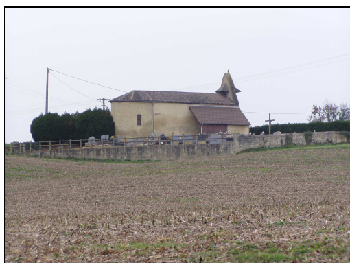
Eglise de Boueilho
