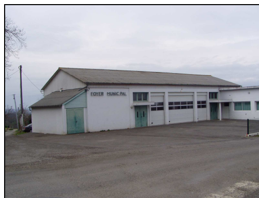
Le foyer municipal
