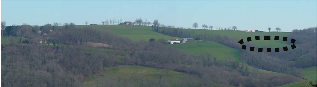
Le site vu depuis le Sud : la ligne de crête est à préserver, une zone constructible est envisagée en contre bas au niveau de la ferme existante
