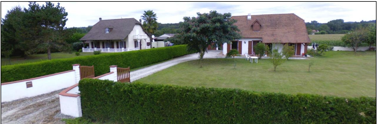
Figure 55 : Maisons récentes, en bordure de la RD n°936, reprenant quelques éléments de l'architecture traditionnelle (façade à gouttereau sous toit pentu, tuiles picon) © ETEN Environnement
