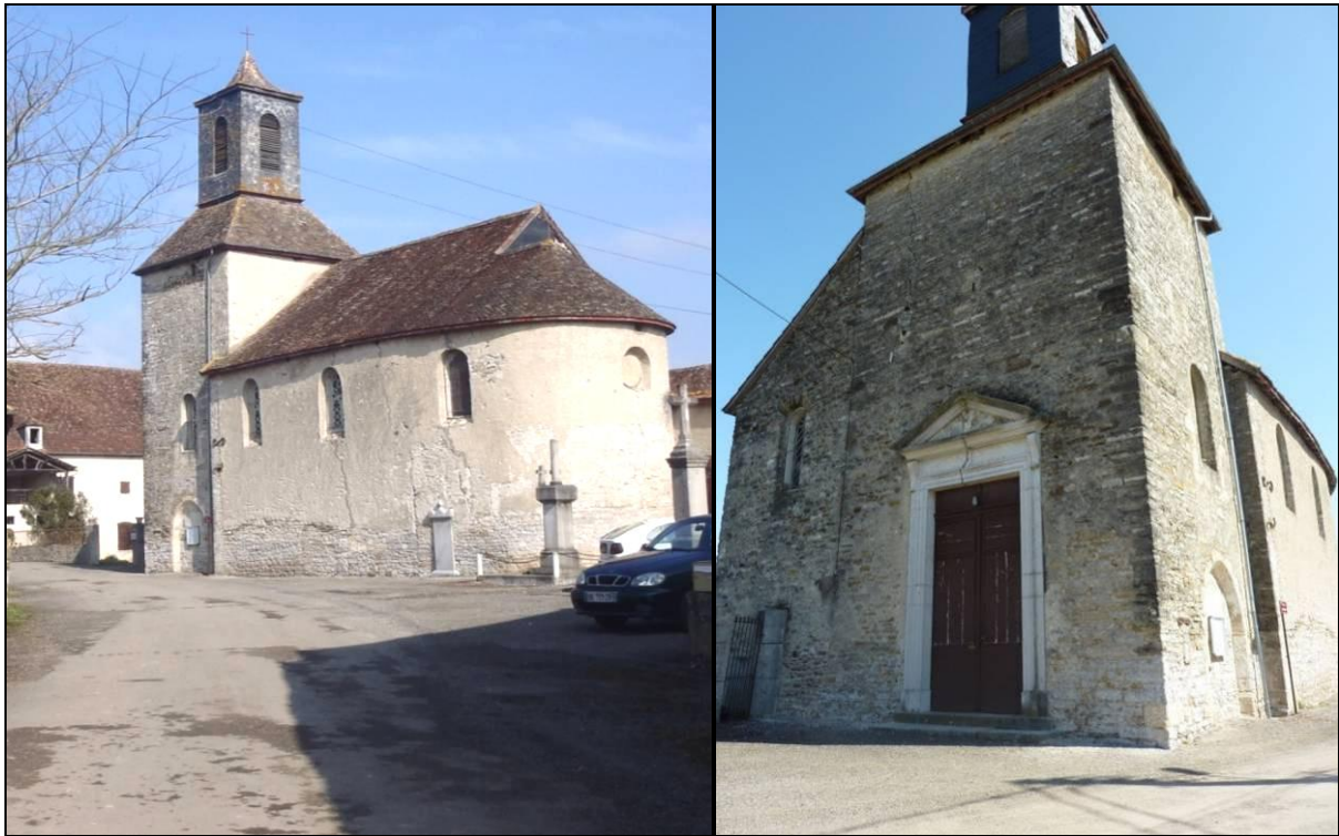
Figure 59 : L'église paroissiale Saint-Cyprien-et-sainte-Justine : elle surgit rapidement depuis la voie communale traversant Barraute © ETEN Environnement
